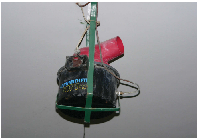
Unidad de humificación en cuarto de almacenamiento
